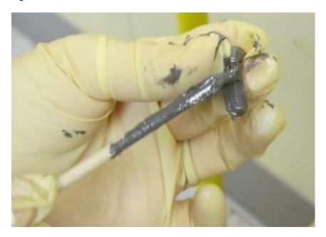
FIGURE 4.6.5 SEALANT BRUSHED ON TO FASTENERS
